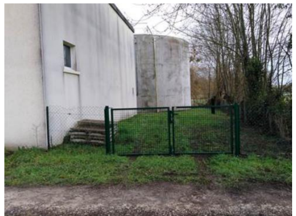
Portail d'accès au PPI côté chemin rural
