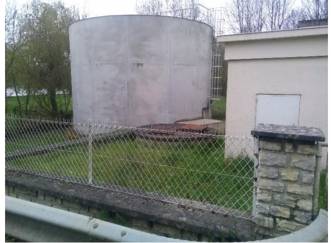
Tête du captage de Basse Terne vue de l'extérieur
