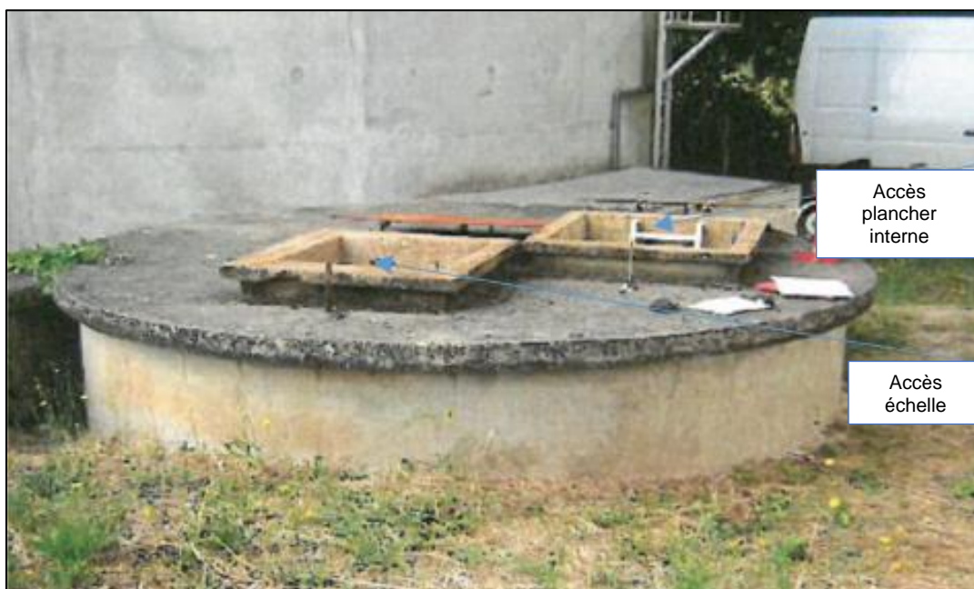
Figure 11 : protection de tête d'ouvrage
