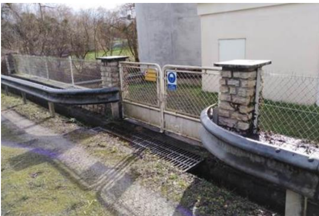
Portail d'accès au PPI côté RD739
